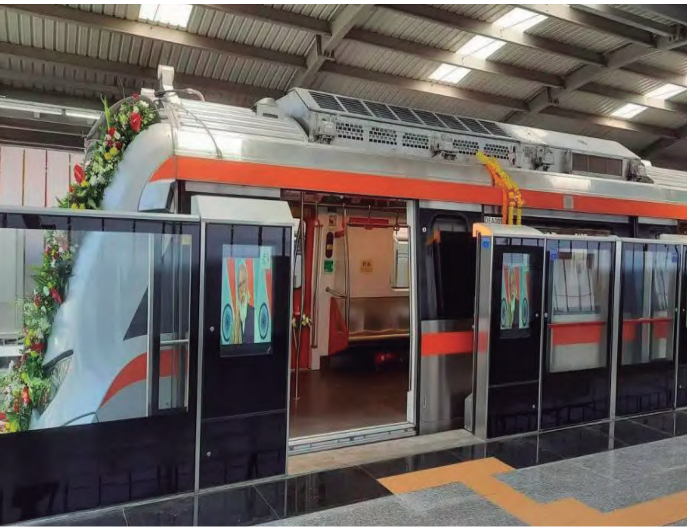
方大智源科技承建轨道交通屏蔽门系统的 印度艾哈迈达巴德地铁一期项目
