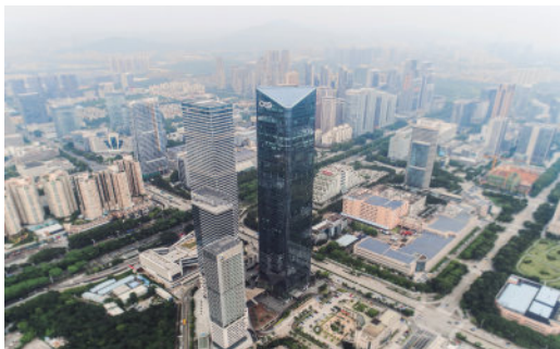
刘兵负责幕墙项目：深圳中国储能大厦
