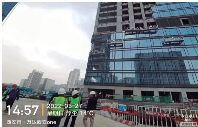
廖吉春在项目现场
