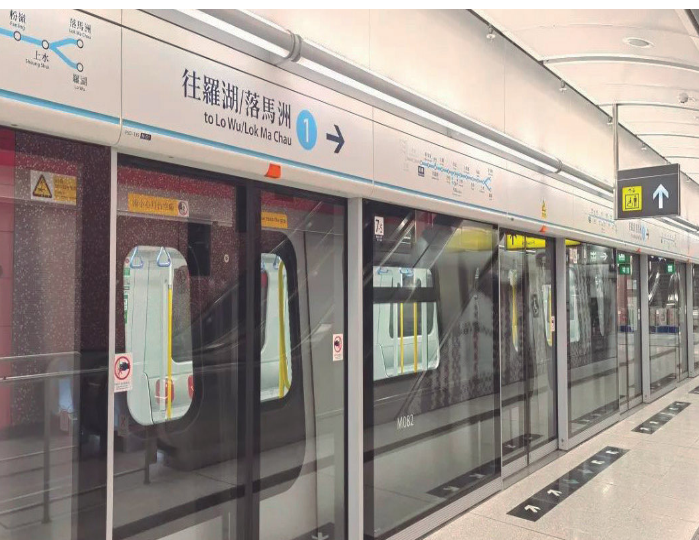
由方大智源科技承建的 香港东铁线过海段屏蔽门系统工程
