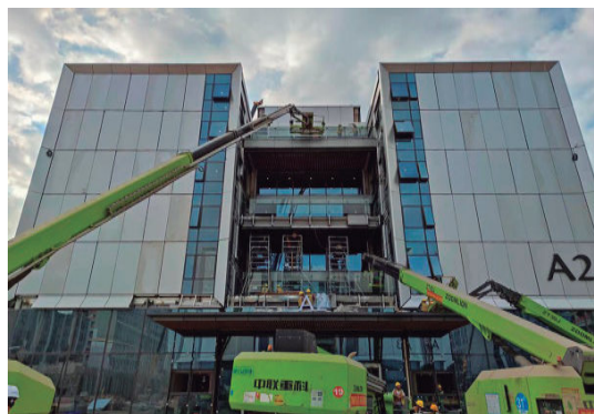
多台曲臂车同时开工
